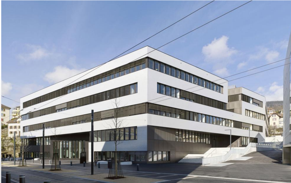
Neuenburg Schweiz, Holz-Verbundkonstruktion
