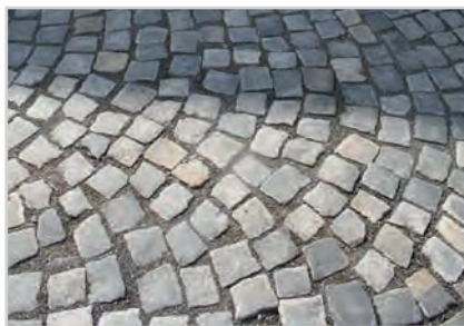
Abbildung 8: Fehlerhafter Pflasterverbund
