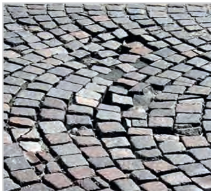
Abbildung 6: Fehlerhafter Pflasterverbund infolge von Absenkungen
