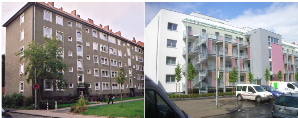
Entkernen und Neubau Johannes-Lau-Hof
