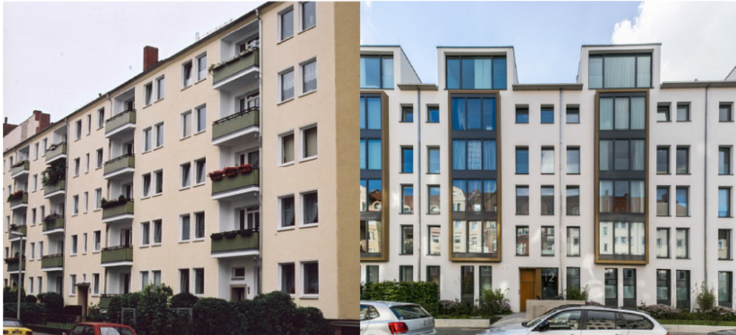
Entkernen und Neubau Grimmstraße
