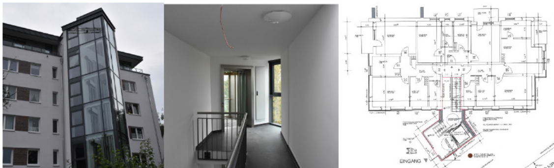
Nachrüstung im bewohnten Zustand Liebigstraße
