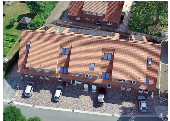
Abbildung: Baufertigstellung Ergänzungsbau (Quelle: Dorfgemeinschaft Hagen e. V.)
