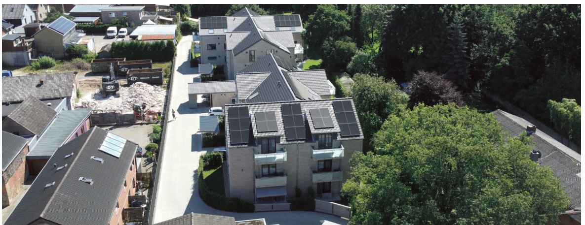
Abbildung: Errichtete Mehrfamilienhäuser nach dem Standard „Erleichtertes Bauen“ (Quelle: KDW eG&R)
